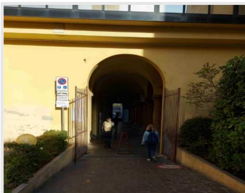
Pad. 4: Entrata - lato Est
