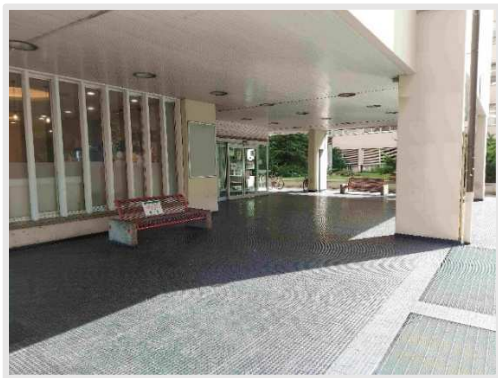
Pad. 2: Entrata - lato Nord
