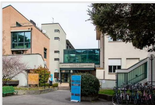
Pad. 8: Ematologia - Ingresso Sud
